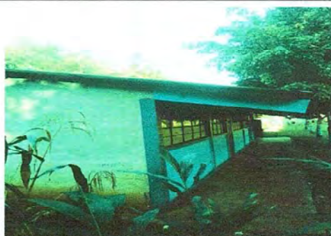
Foto 3: Mantenimiento de piso
