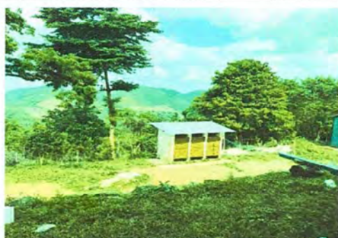
Foto 5: Sustitucion de cubierta de laminas
