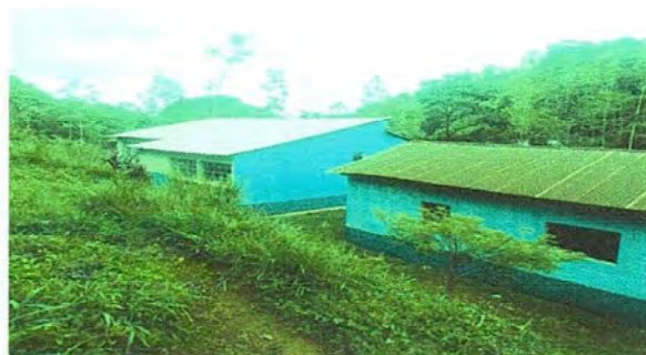
Foto1: Cubierta de laminas nuevas
